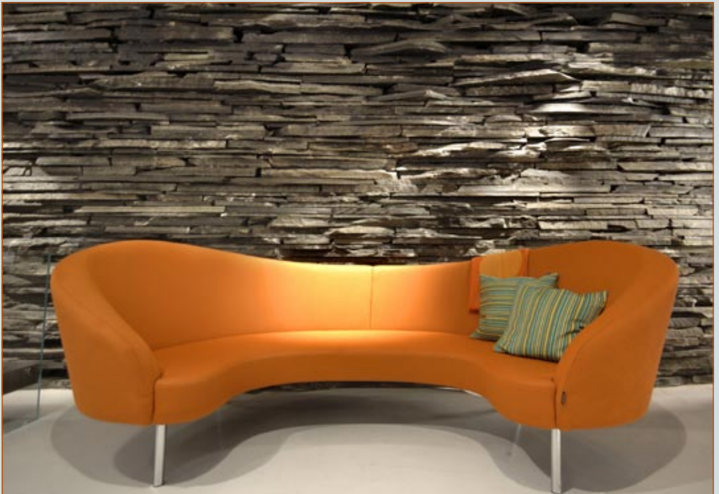
Tørrmur (10-30 cm) i Altaskifer til forblending
