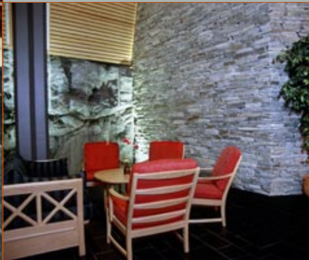
Tørrmur 15-30 i Oppdalskifer og flis i Ottaskifer
